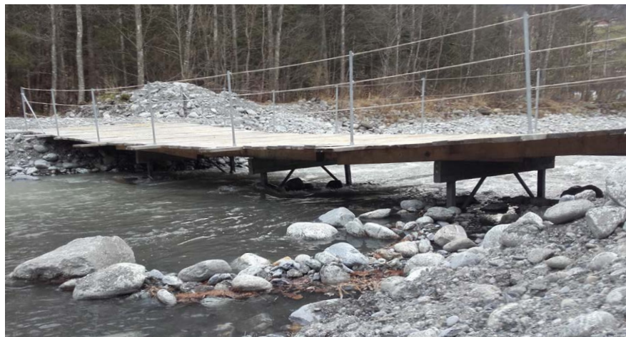
Abb. 3 temporäre Brücke Schwarze Lütschine Almisey (auf diese wird zukünftig verzichtet)
