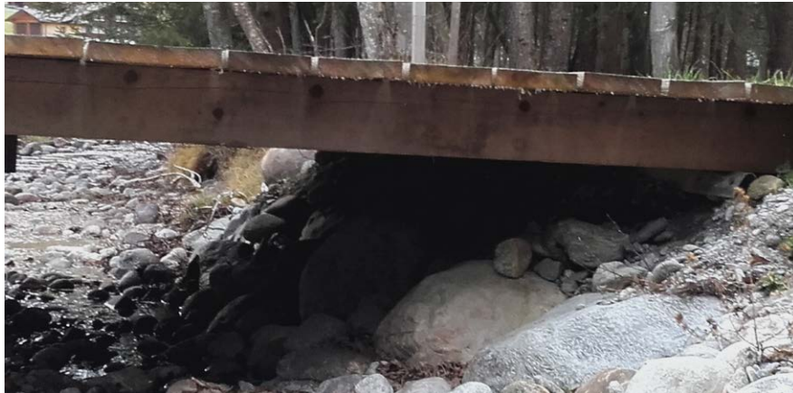
Abb. 24 Querung Schüsslerengraben (West) [Geidelgraben]; nicht Gegenstand der UeO
