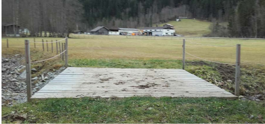
Abb. 23 Querung Schüsslerengraben (West) [Geidelgraben]; nicht Gegenstand der UeO
