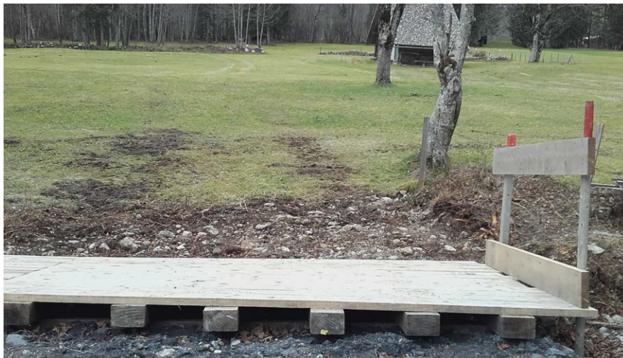
Abb. 21 Schüsslerengraben (Ost) [Geidelgraben]; nicht Gegenstand der UeO
