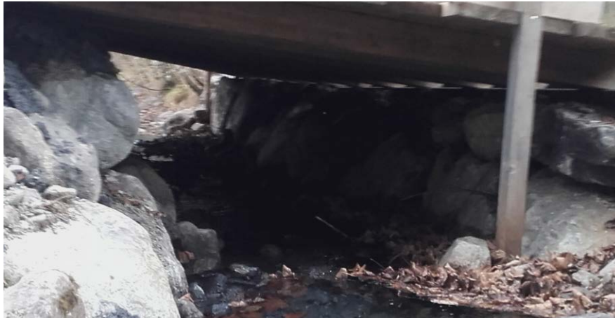
Abb. 20 Schüsslerengraben (Ost) [Geidelgraben]; nicht Gegenstand der UeO
