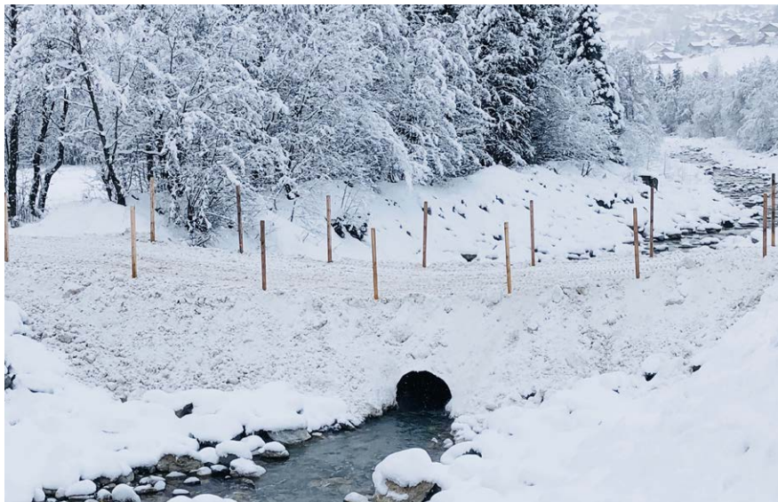
Abb. 19 Seitliche Anrampung mit Schneeüberdeckung (wird in Zukunft analog Anhang A ausgeführt)
